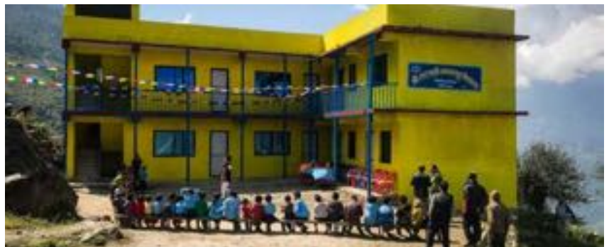
Bild 29: Die fehlenden 3 Klassenräume im ersten Stock wurden fertiggestellt.
