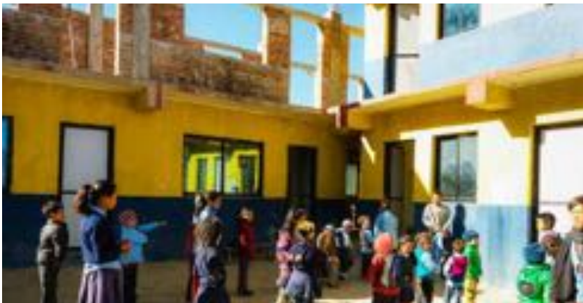
Bild 35: Die 3 neuen Räume werden gebaut.
